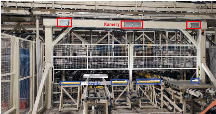
Konstrukce kamerového „držáku“ + podsvitu měřených profilů
